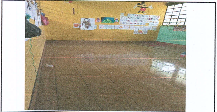
Foto 5. PISO REMOZADO DENTRO DE LAS AULAS.
